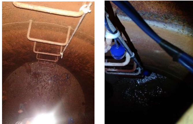
Gambar. 6 Pemasangan level sensor pada tangki 562-IJ1
