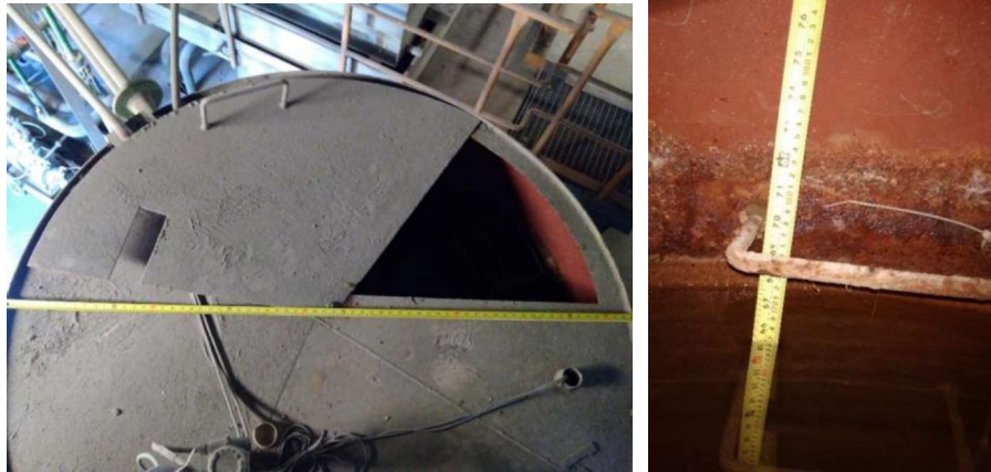
Gambar. 2 Pengukuran diameter dan ketinggian tangki water injection 562-IJ1
