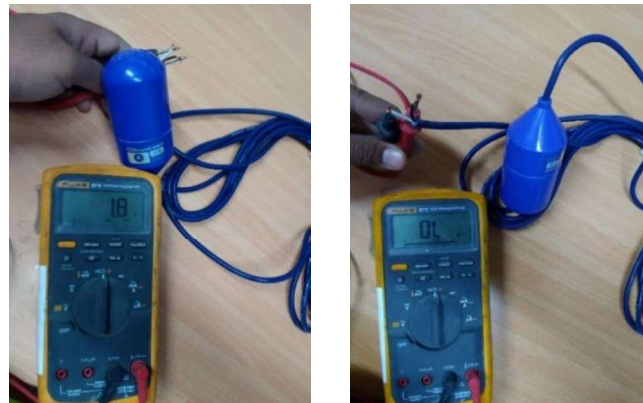
Gambar. 3 Pengujian level sensor sebelum dipasang
