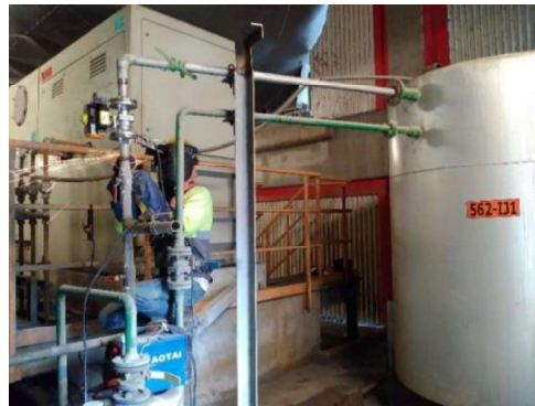
Gambar. 7 Pemasangan control valve pada pipa input tangki 562-IJ1
