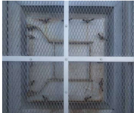
Gambar 1. access door manhole pada HRSG PLTGU Grati:
