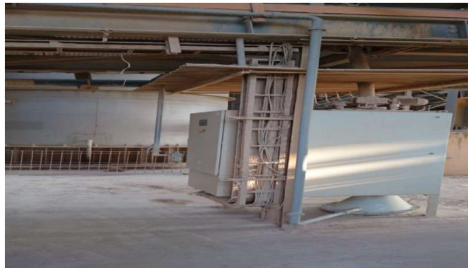
Gambar 4 Bentuk saluran pengembali material raw meal setelah modifikasi
