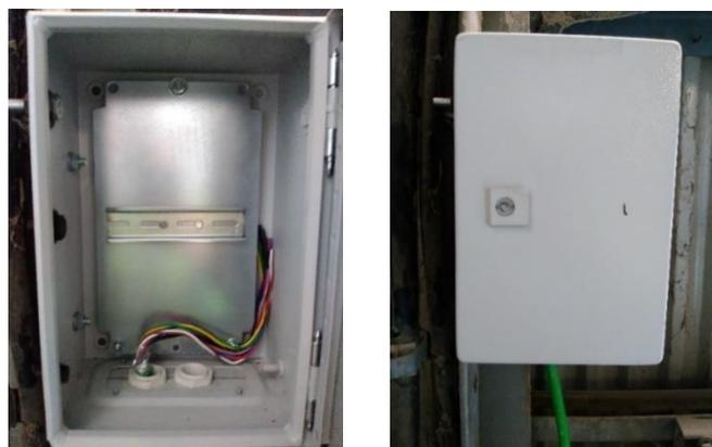
Gambar. 5 Panel lokal untuk *control valve* 562-IJ1
