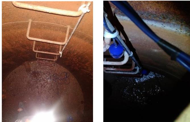
Gambar. 6 Pemasangan level sensor pada tangki 562-IJ1
