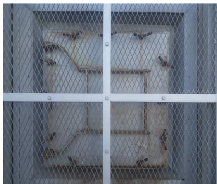
Gambar 1. access door manhole pada HRSG PLTGU Grati:
